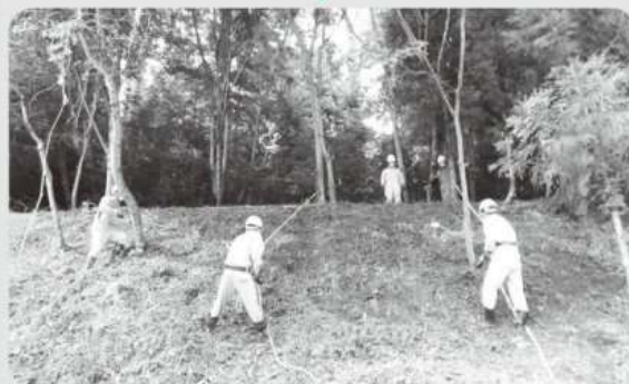
③ 法面の表土除去
