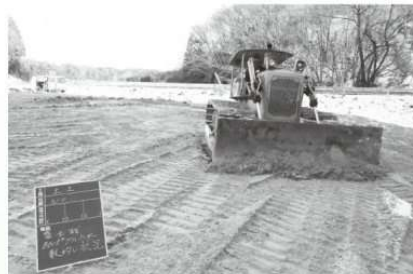
③下地に盛土をして平らにします。
