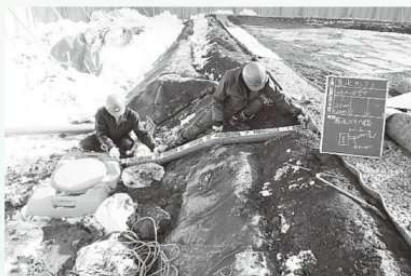
⑦暗きょ排水管を集水タンクにつなぎます。
