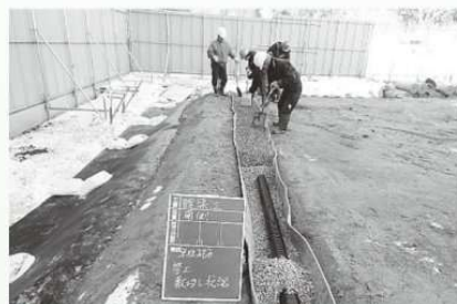
⑥保護層の中に暗きょ排水管を入れます。
