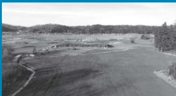
原形復旧工事中の今坂仮置場
