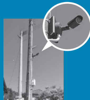
西小屋に設置された防犯カメラ
