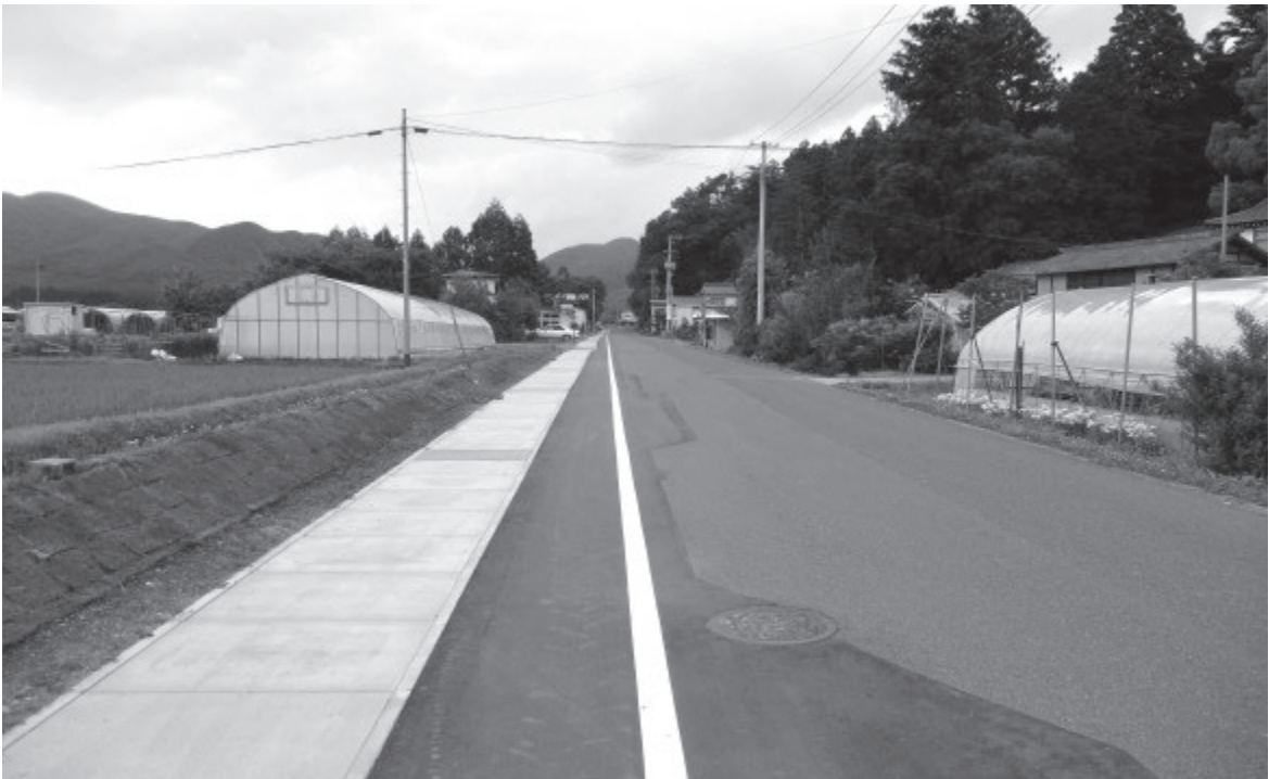
有効幅員を広げる工事を行った児渡滝田線
