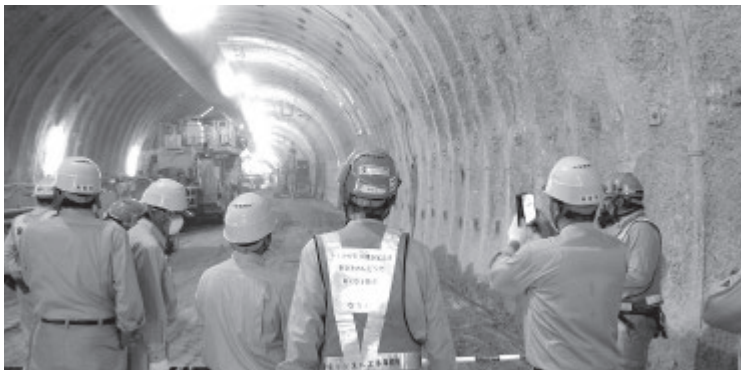
トンネル入口から約200m付近で掘削工事を視察
