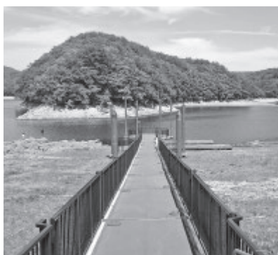
議論となった浮棧橋
