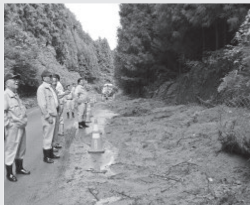
崩落した戸ノ内丸山線
