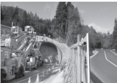
鳳坂トンネル
