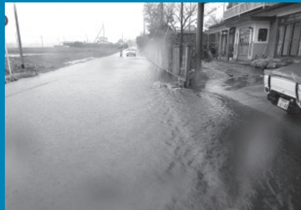
台風の影響による冠水
