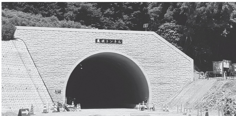
7月4日現在の鳳坂トンネル
