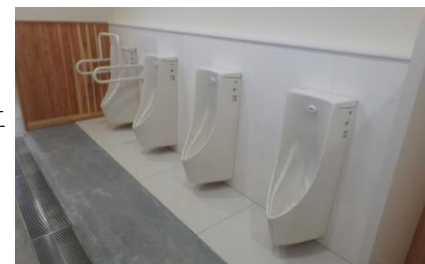
右) 節水型衛生機器の施工
