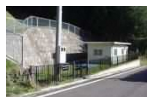
愛宕山配水池(第4配水)
