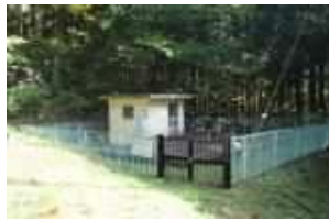
大平簡易水道配水池
