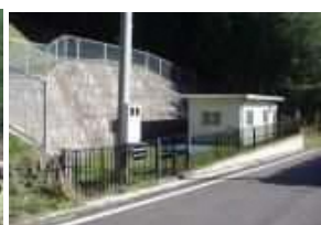
愛宕山配水池(第4配水池)
