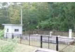
二岐専用水道配水池
