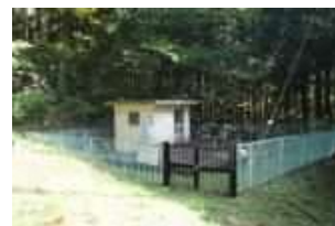
大平簡易水道配水池
