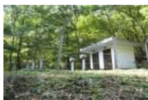
野仲簡易水道配水池
