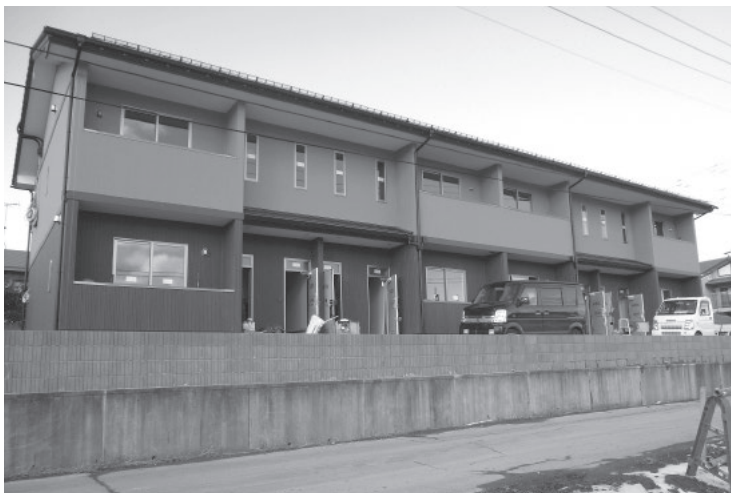
建設中の集合住宅
