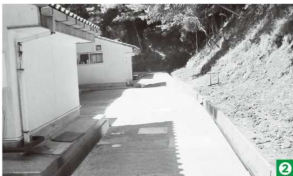
幼稚園裏の作業前①と作業後②の様子
