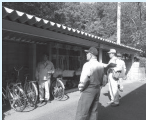
天栄中学校ブロック塀の状況調査
