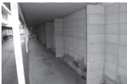
改修予定のブロック塀
