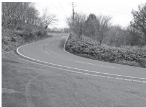
急こう配のため交通事故が懸念される村道芝草鎌房線
