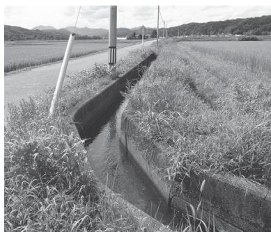
村内の用水路
