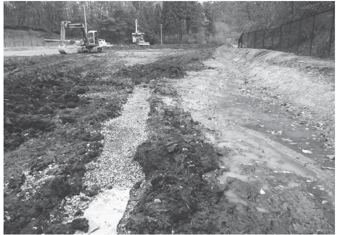
工事現場の様子
