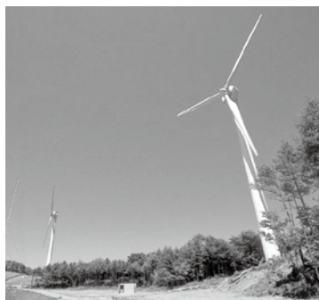
天栄風力発電所
