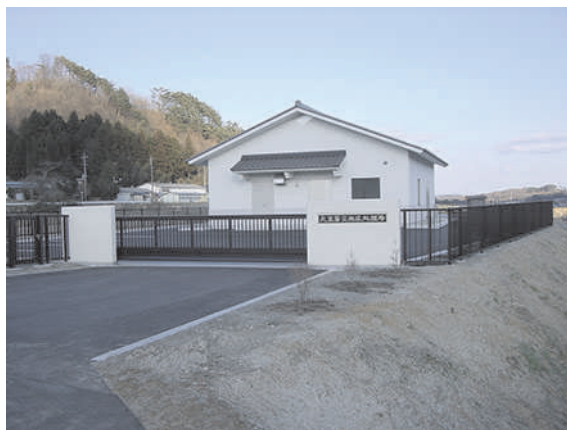
農業集落排水処理施設
