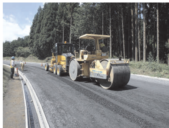
道路改良状況
