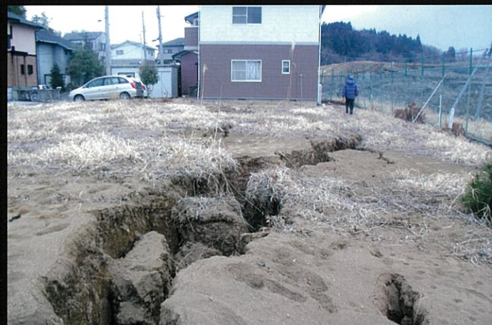
春日山地区の地割れ
