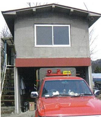
被災した消防団(西郷)屯所
