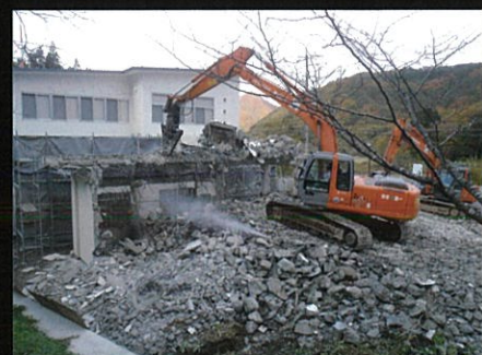
被災した湯本支所の解体
