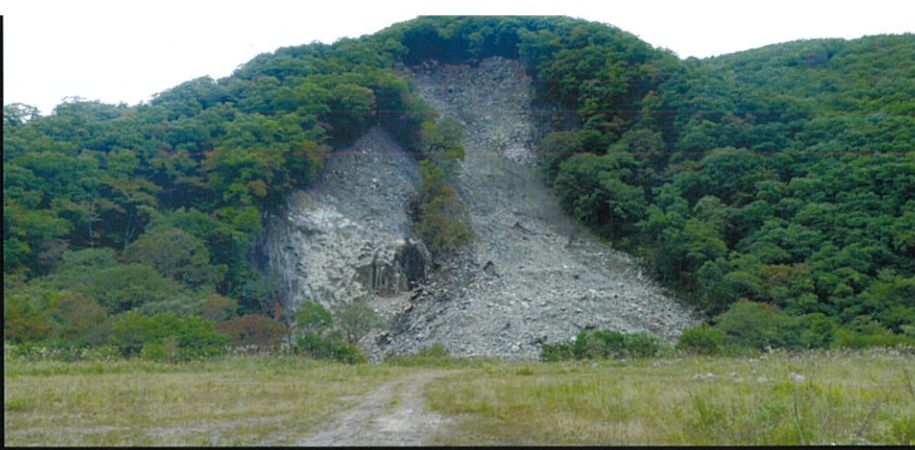
戸倉山の崩落
