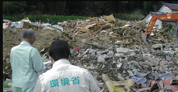
震災がれき置場
