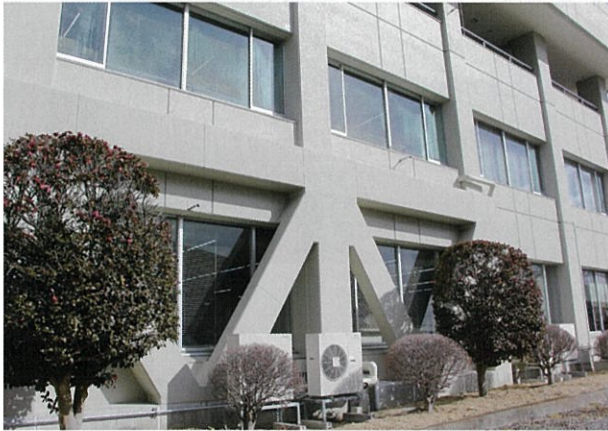
庁舎の耐震補強
