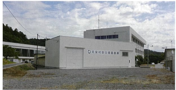
震災後に整備された防災備蓄倉庫
