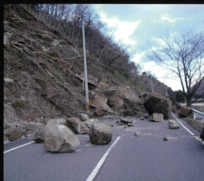
後藤地区の山地崩落
