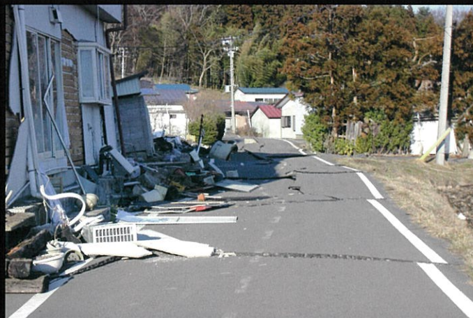
滝田地区の被災した家屋
